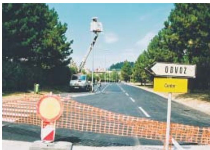
Gorica, 21. 8. ob 13. uri: Tik pred odprtjem Goriške ceste, pod katero je zgrajena nova kanalizacija.
